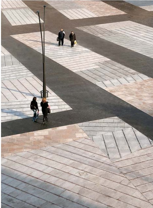
Pavimentazione Piazza Jean Jaurés a Saint-Denis
