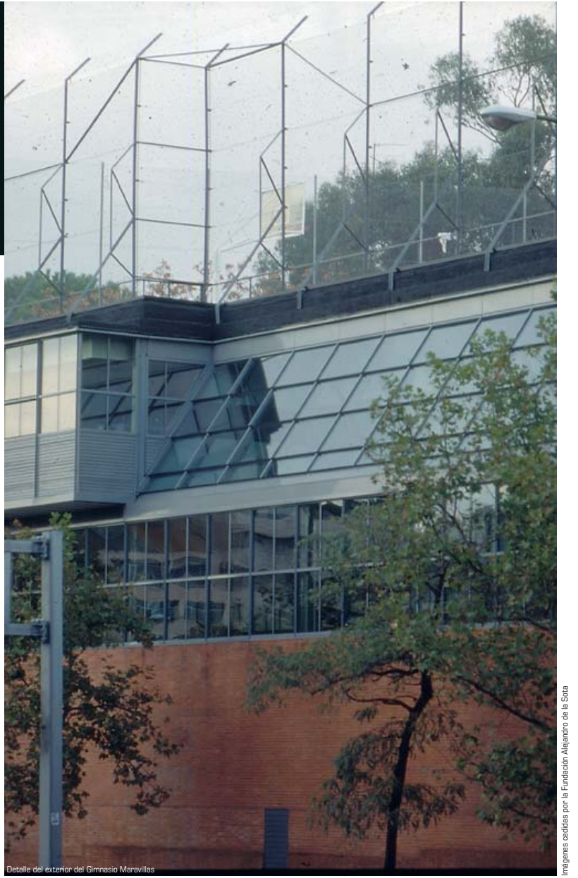
Detalle del exterior del Gimnasio Maravillas
