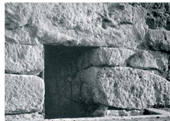
Tarragona, puerta cíclica de la muralla antigua
