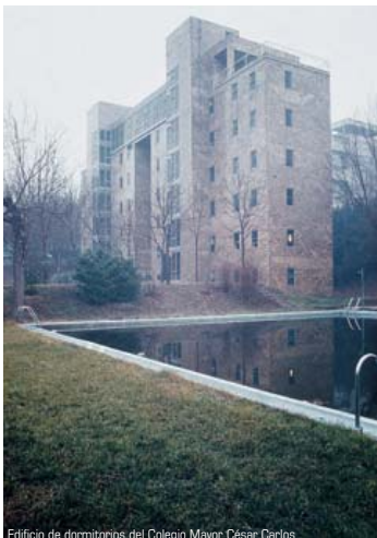
Edificio de dormitorios del Colegio Mayor César Carlos
